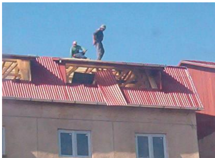
Fig.3 Pe acoperiș, la mansardarea unui bloc cu 4 nivele
