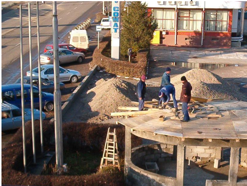
Fig. 1 Muncitori efectuând lucrări la înălțime.
