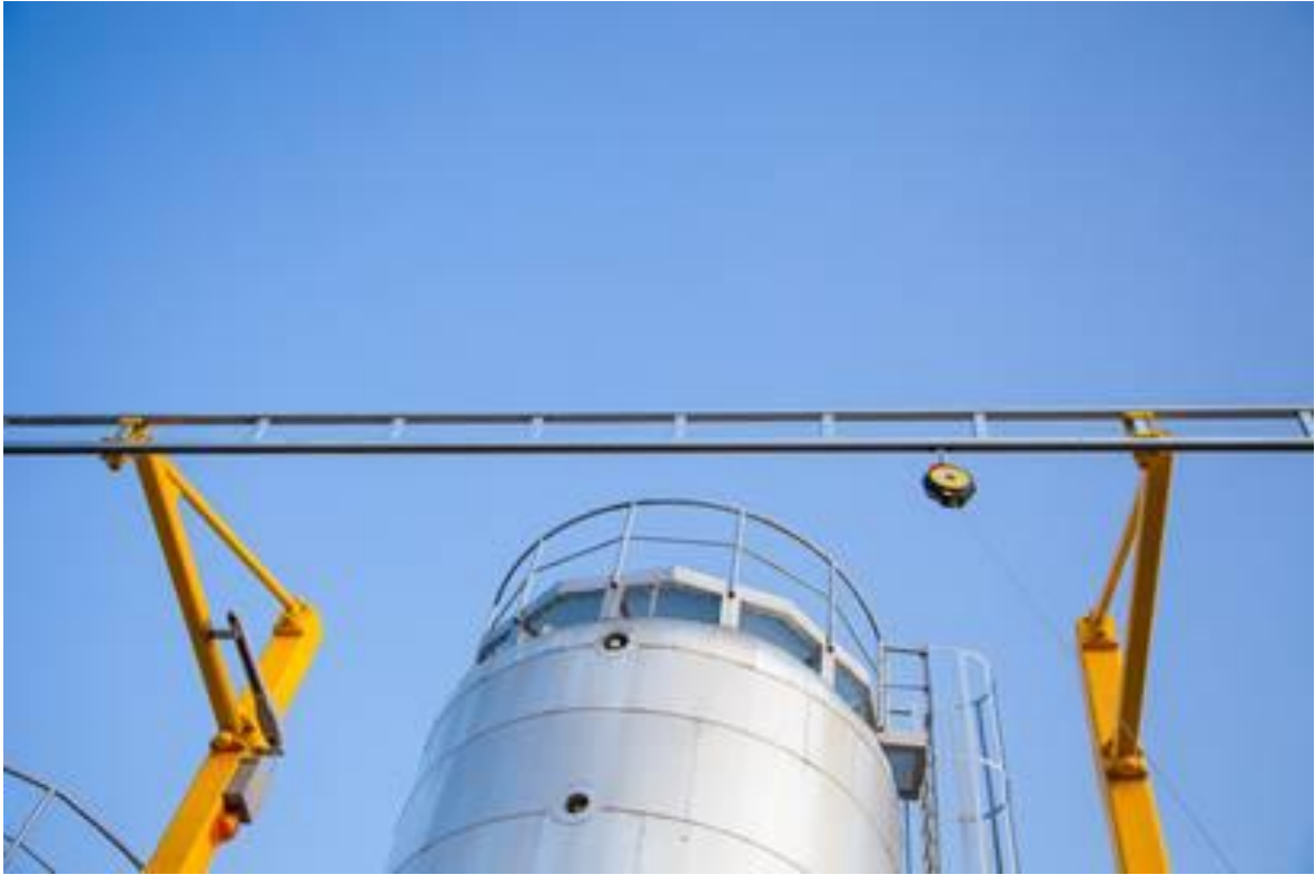
Lifeline orizontal, (overhead), la o stație de descărcare vagoane
