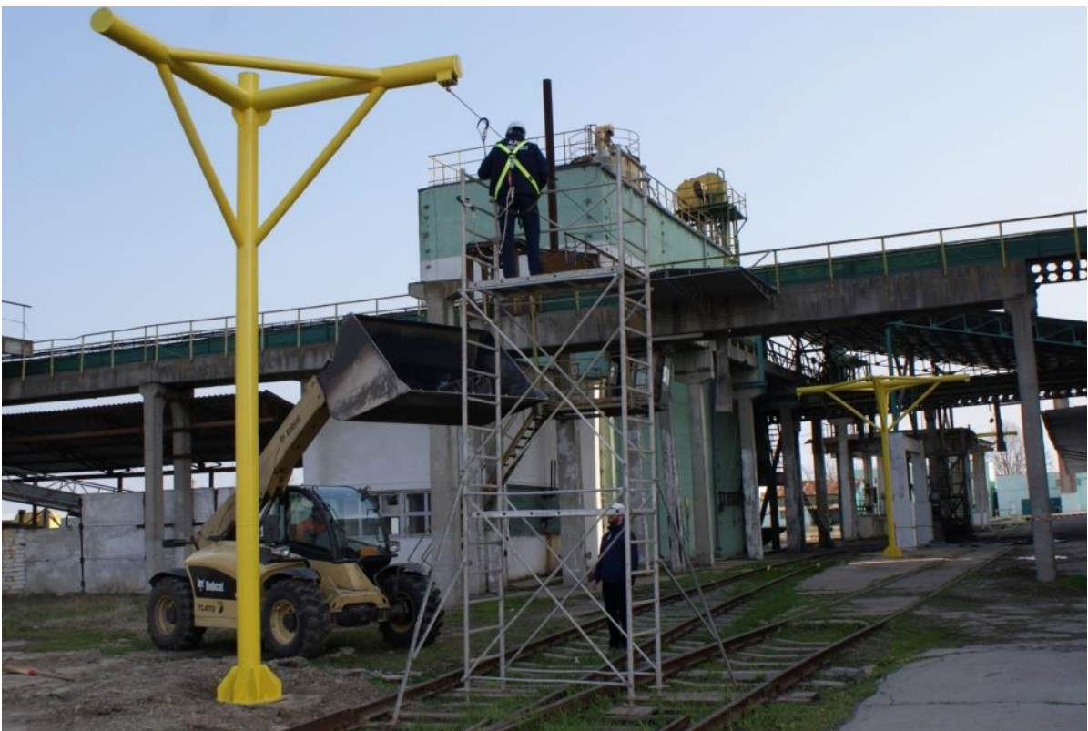
Lifeline orizontal, (overhead), la o stație de descărcare vagoane
